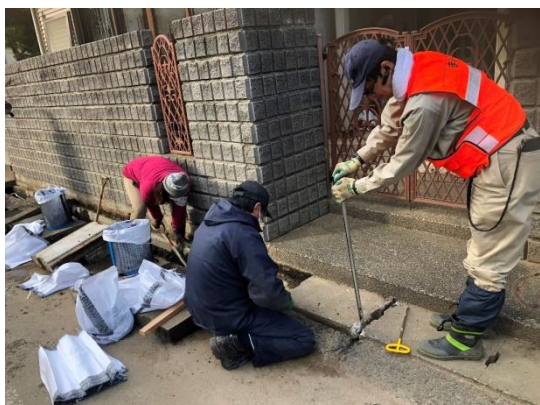
写真VI-2 側溝の泥出し作業風景
