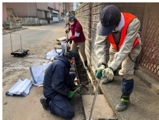
写真VI-2 側溝の泥出し作業風景
