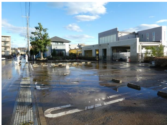
写真IV-4 認定みどり幼稚園前の浸水痕
