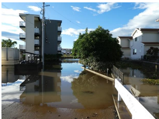
写真IV-5 冠水状態の集合住宅駐車場
