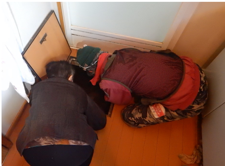
フローリングの床下の確認
